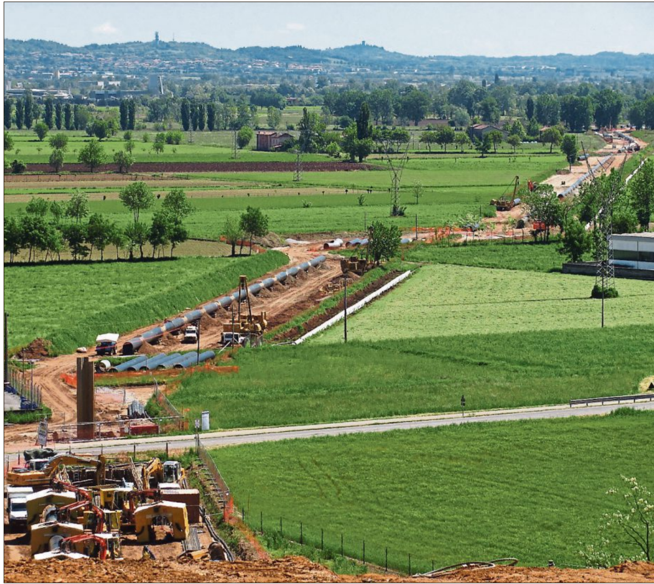
Rund 200 Streicher-Mitarbeiter sind auf der Pipelinebaustelle in Italien tätig.
